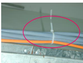
Чрезмерно сильная затяжка фиксирующей стяжки
