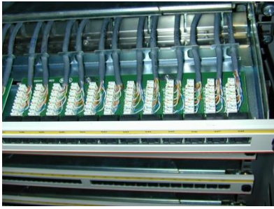
Торцевой фитинг с ограничением минимального радиуса изгиба кабеля
